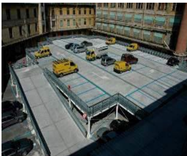
Struttura multipiano nell'ex Manifattura
