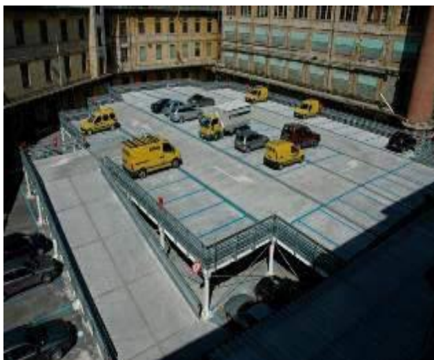
Struttura multipiano nell'ex Manifattura
